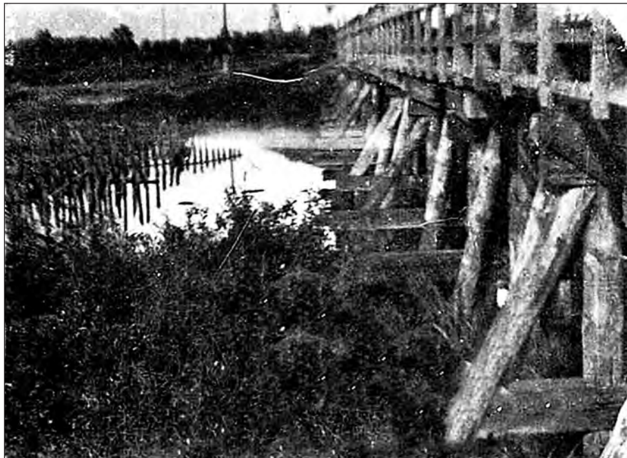
Droga nad Bug. Drewniany most na Konowicy
