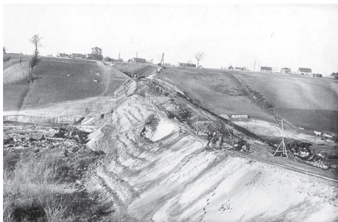
Budowa linii kolejowej Toruń – Sierpc (bazakolejowa.pl)
