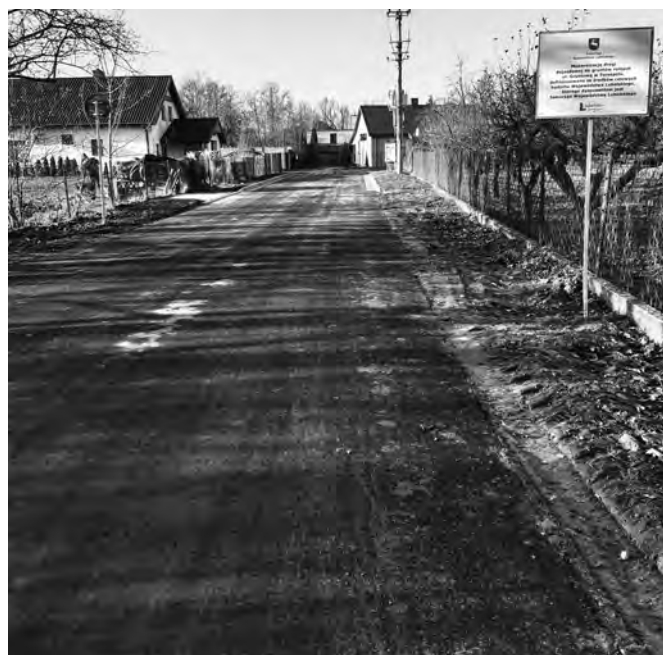
Remont ulicy Gruntowej
