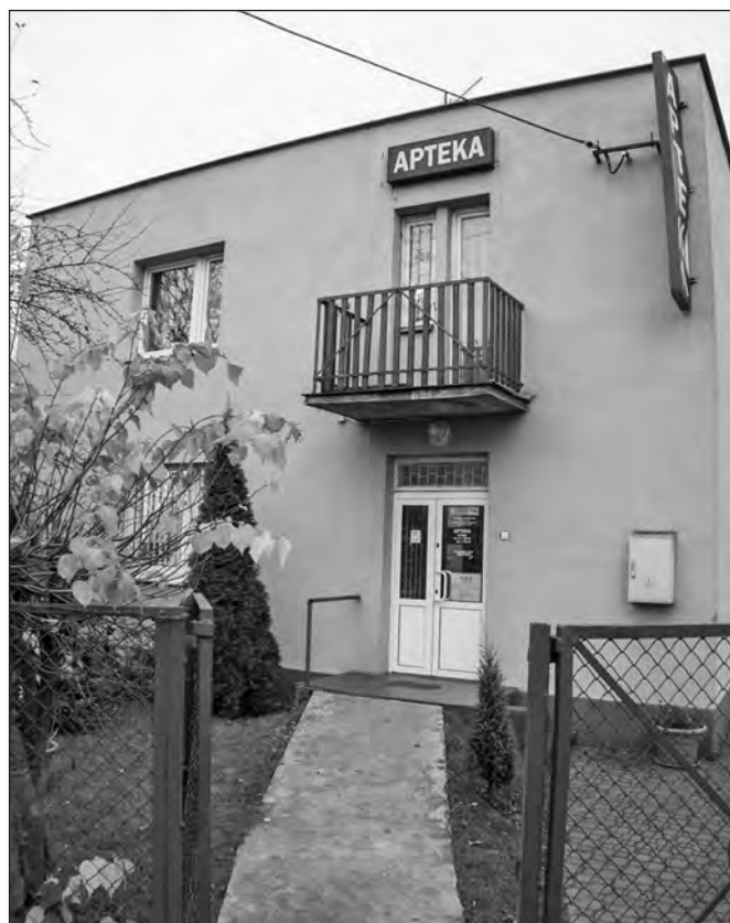
Apteka, widok od ul. Stacyjnej
