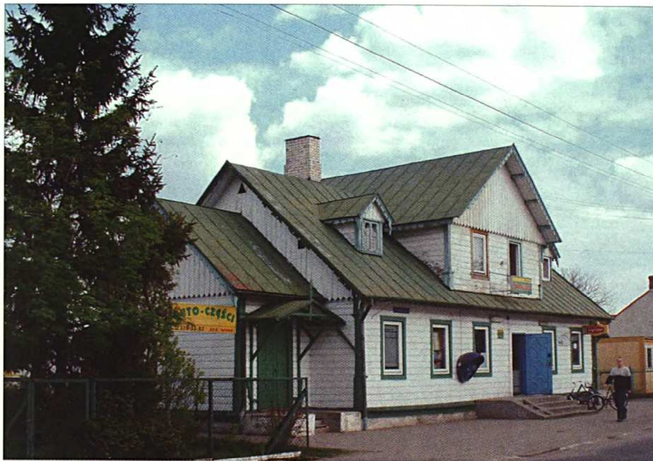
Drewniana architektura przy ul. Czerwonego Krzyża.
