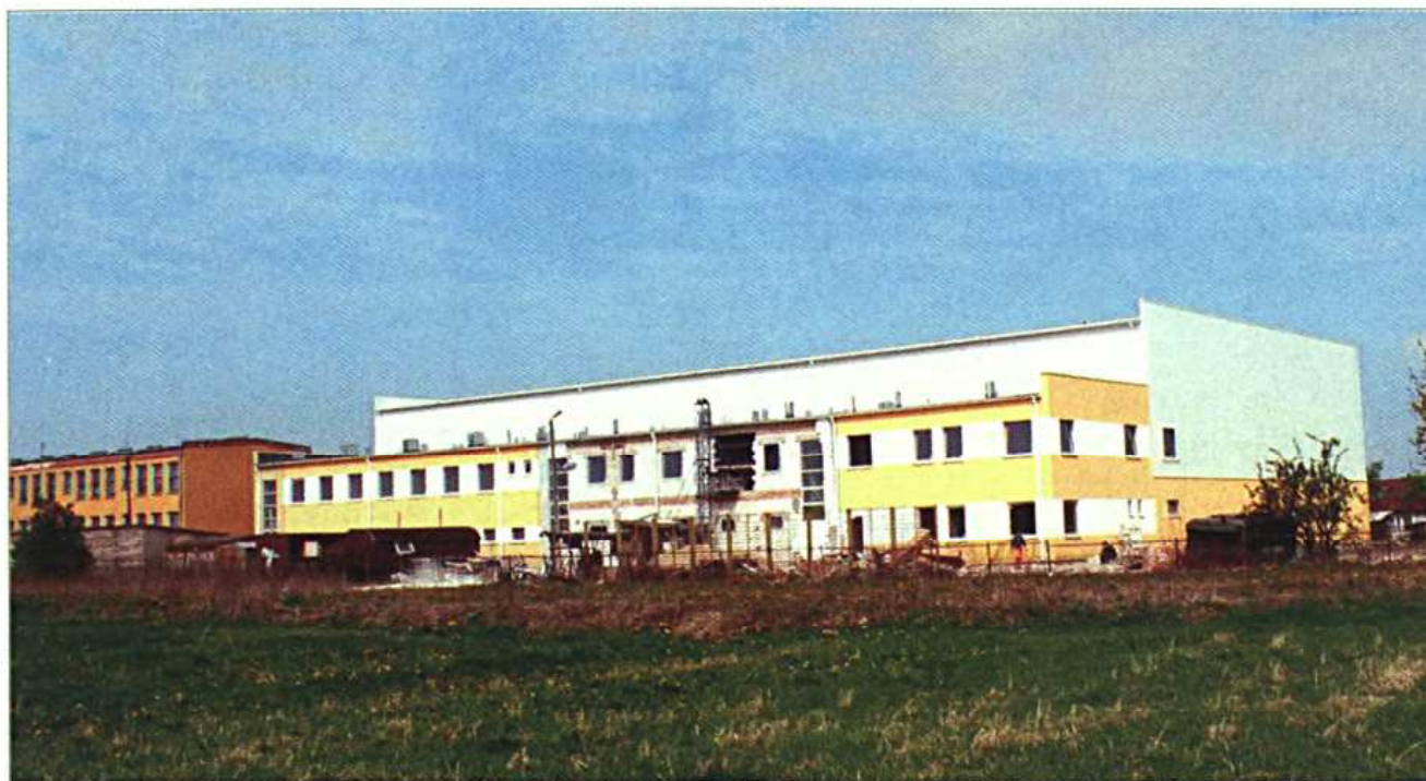
Hala sportowo-widowiskowa w budowie.
